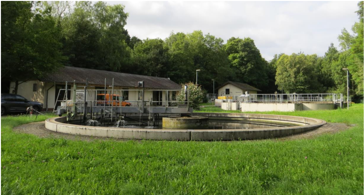
Abb3: Blick in Richtung Südwesten auf das Betriebsgebäude, das Nachklär- und Belebungsbecken
