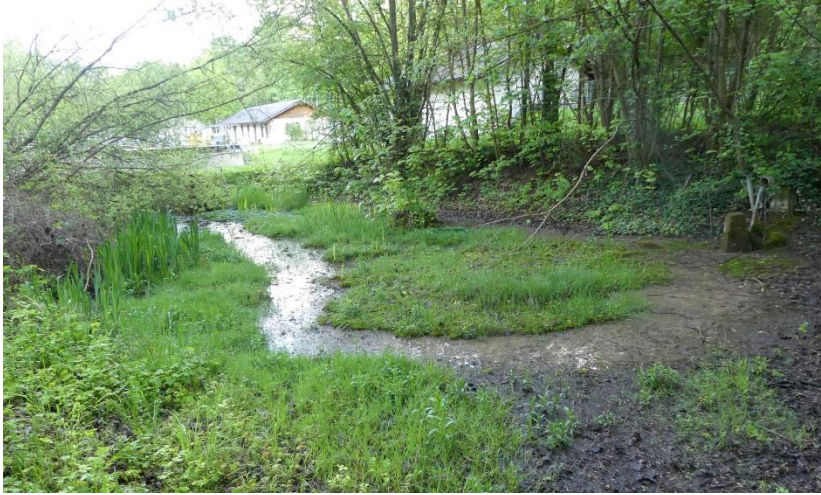
Abbildung 10: Ungefüllter Teich, Kläranlage Eistal-West
