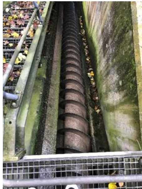
Abbildung 14: Schneckenpumpe
