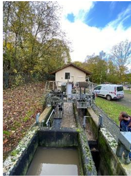
Abbildung 21: Sand- und Fettfang
