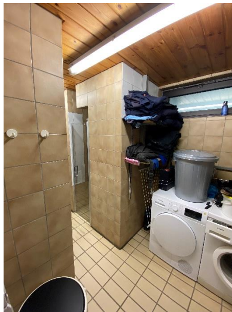
Abbildung 53: Umkleide mit Dusche
