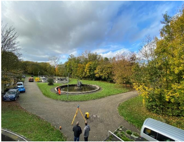
Abbildung 60: Blick auf die Kläranlage (Einlauf und Biologie)
