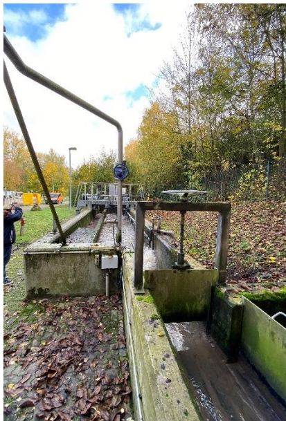
Abbildung 22: Einlaufbereich Sandfang
