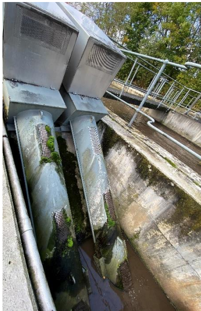
Abbildung 38: Rücklaufschlamm-pumpwerk
