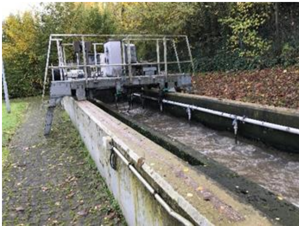
Abbildung 20: Sand- und Fettfang
