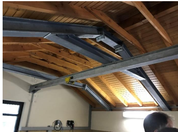
Abbildung 19: Kranbahn im Rechengebäude
