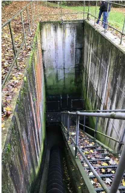
Abbildung 15: Zulaufpumpwerk
