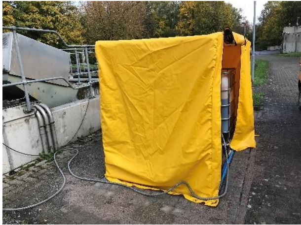
Abbildung 40: Prov. Fällmittelstation
