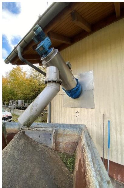
Abbildung 25: Abwurf in den Sandcontainer
