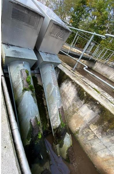
**Abbildung 38: Rücklaufschlamm-pumpwerk**
