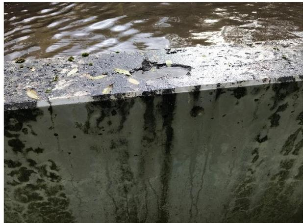
**Abbildung 33: Schäden am Belebungsbecken**
