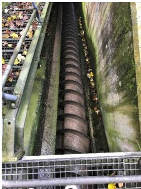
Abbildung 14: Schneckenpumpe
