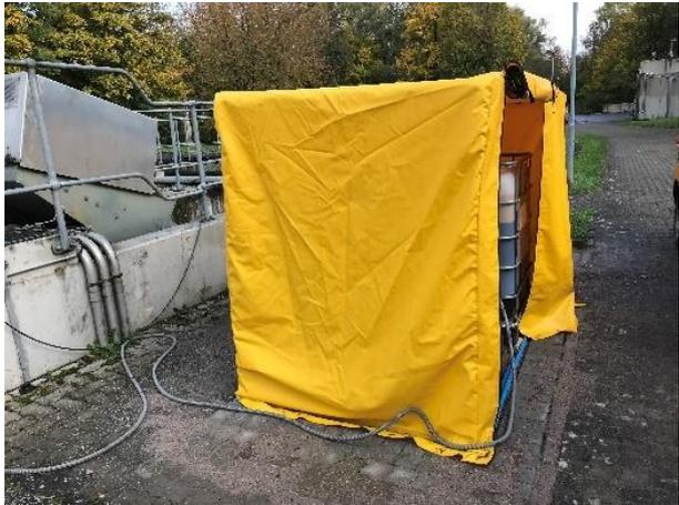
Abbildung 40: Prov. Fällmittelstation
