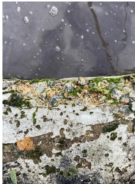
Abbildung 37: Schäden am Belebungsbecken
