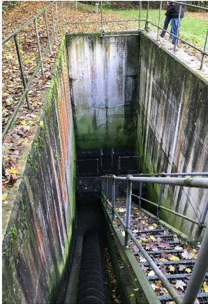
**Abbildung 15: Zulaufpumpwerk**
