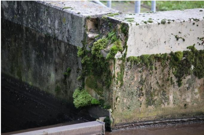
Abbildung 34: Schäden am Belebungsbecken
