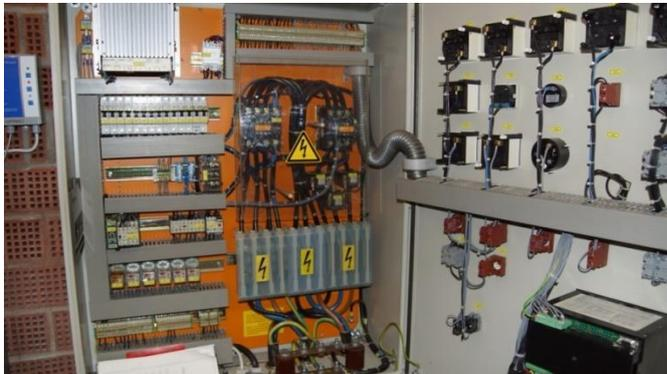
**Abb. 14** Schaltanlage Notstromgenerator
