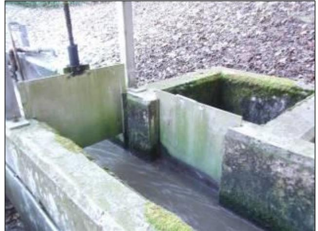
**Abb. 24** Belüfteter Sandfang mit Räumerbrücke, Absperrschieber
