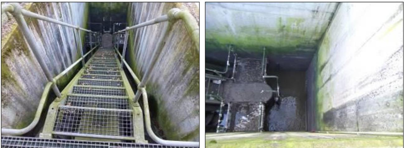
**Abb. 21 Pumpensumpf des Schneckenhebewerks**
