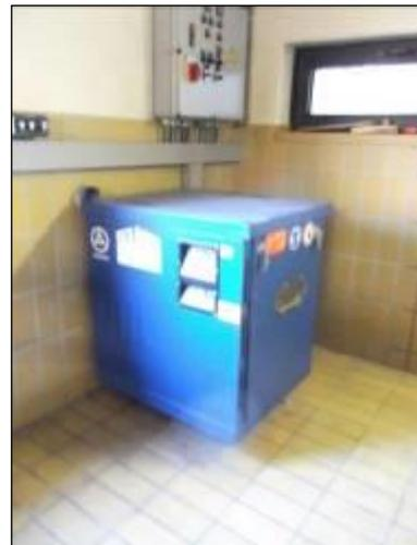
**Abb. 22      Antriebsmotoren, Gebläse (nicht ex-geschützt)**
