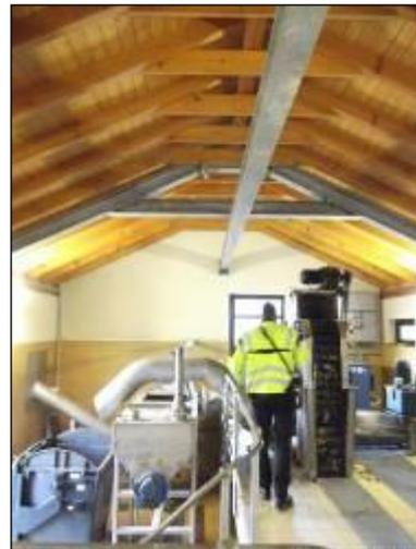
**Abb. 23** Antrieb der Rechenanlage, Kranbahn im Rechengebäude
