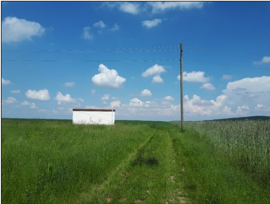
Abbildung 8 Blick Richtung Nordosten - Trafogebäude; im Vordergrund links künftiger Spielplatz - rechts künftiges WA; Mast der 20 kV-Mittelspannungsleitung wird abgebaut
