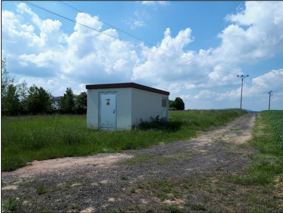
Abbildung 7 Blick Richtung Nordwesten - Trafogebäude; im Hintergrund künftiger Spielplatz
