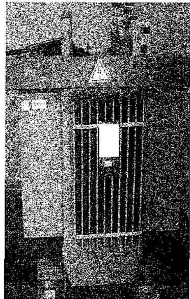
Abb. 4: Öltransformator einer Freiflächenphotovoltaikanlage (Bildquelle: LfU)
