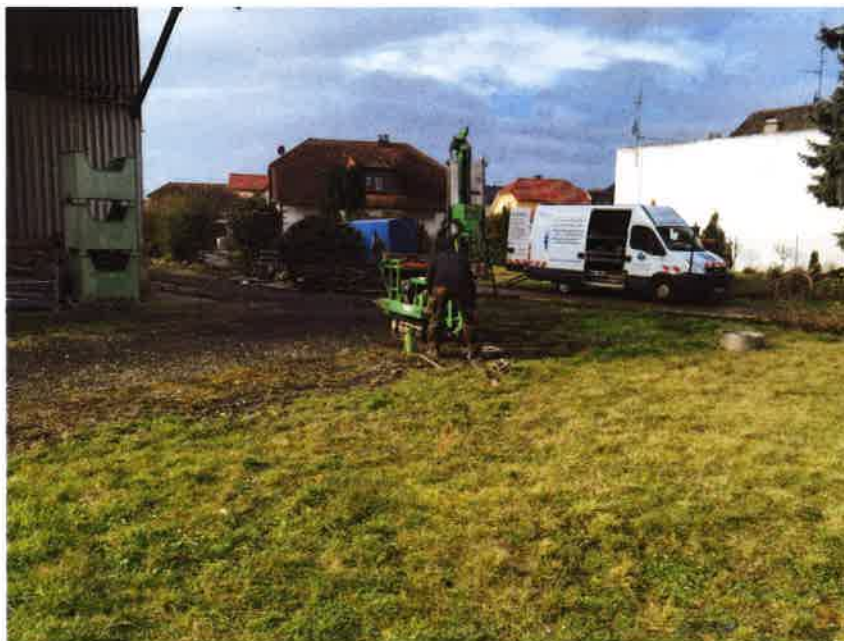
Baugrunderkundungen am 15. März 2021 - BS 1
